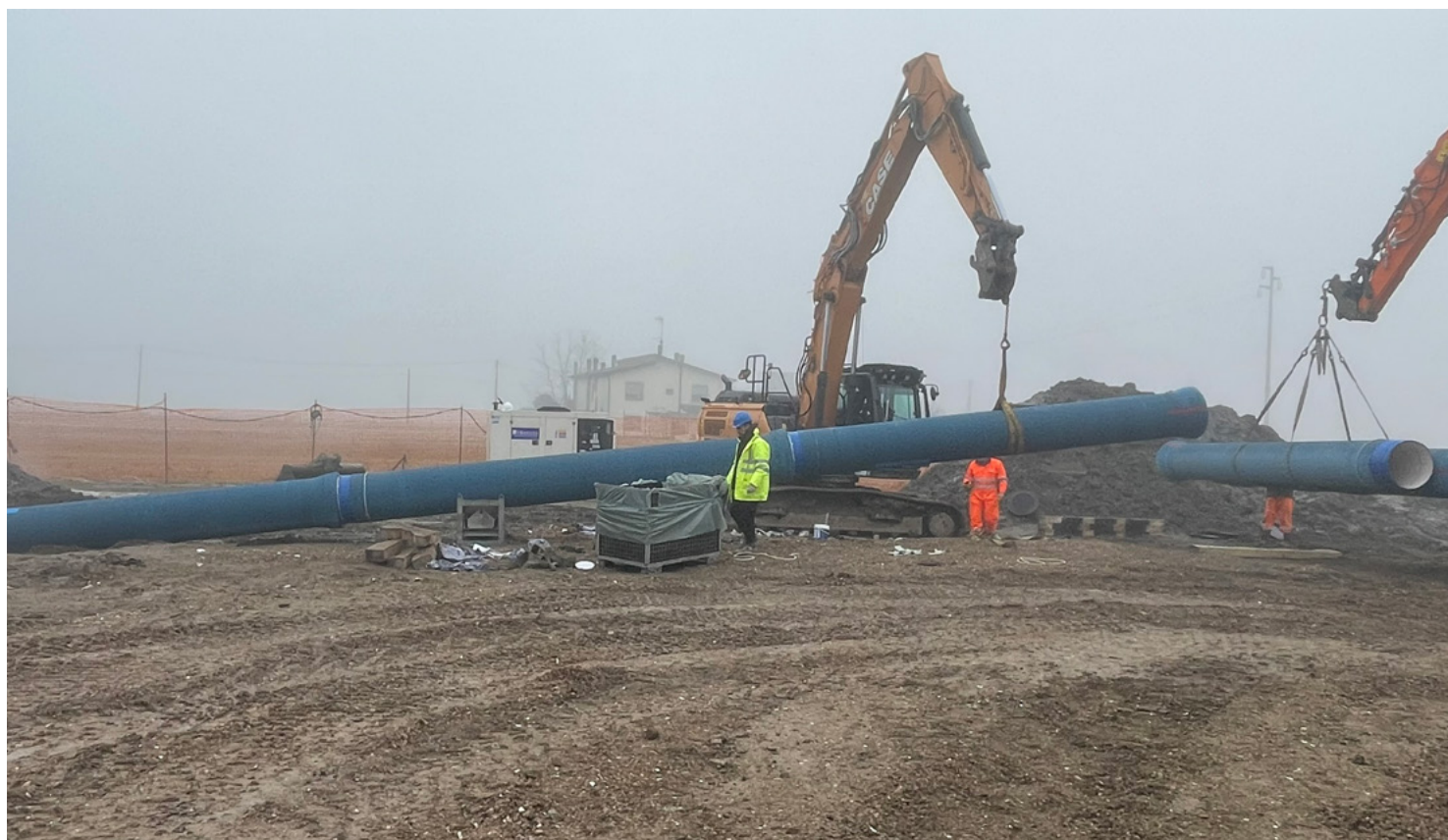
Assemblaggio tubazioni durante le fasi di varo mont and pull
