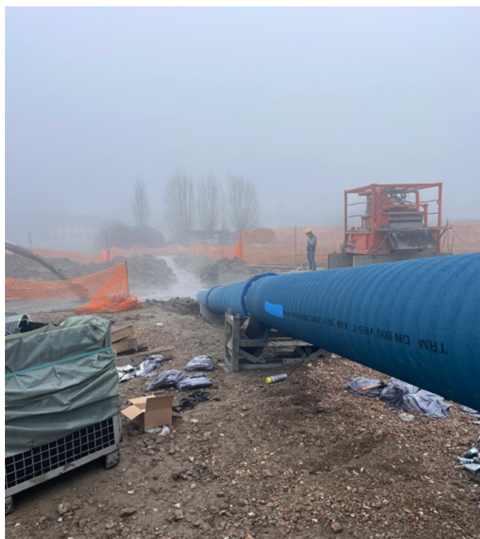
Tubazione in ghisa sferoidale con rivestimento esterno in malta di cemento
