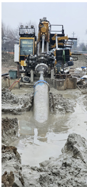
Uscita tubazione lato rig
