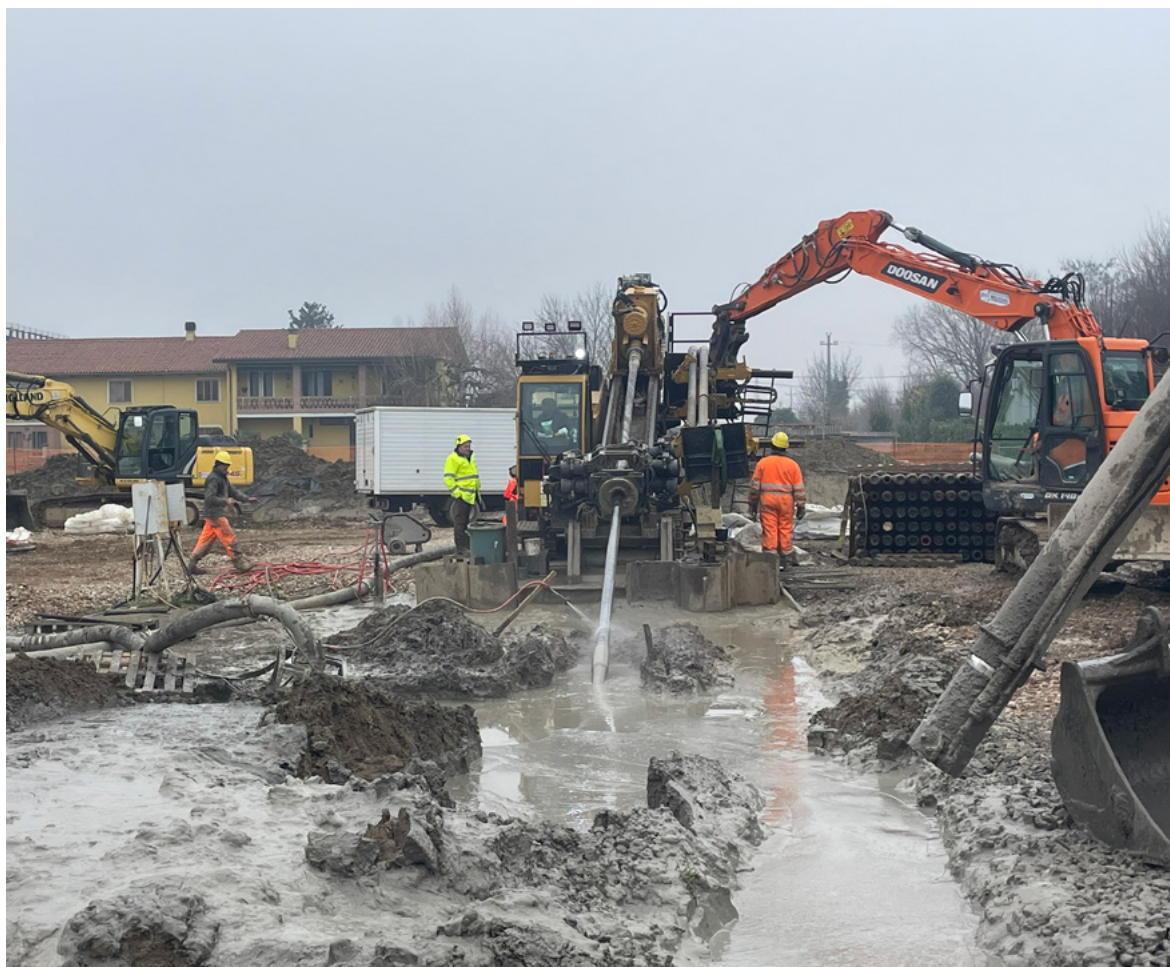
Area di cantiere lato rig
