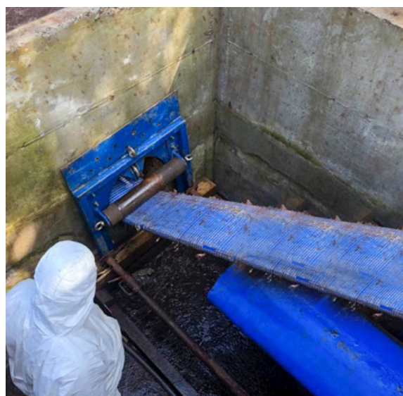
Fasi di inserimento della manichetta armata
