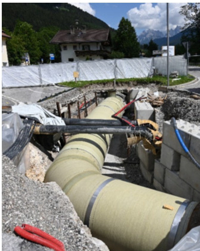
Tubazioni in PRFV installate all'interno di uno scavo dopo il montaggio dei manicotti esterni in acciaio
