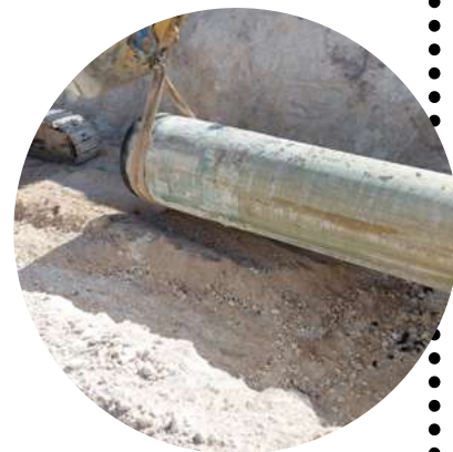
Il sistema di protezione meccanica pau wrap® durante le prove con sistema Direct Pipe in Puglia
