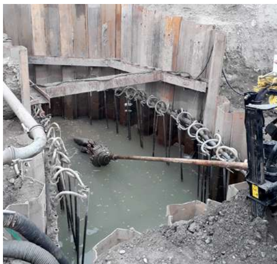
Recupero della TOC abortita in corrispondenza dello svincolo autostradale di Avigliana
