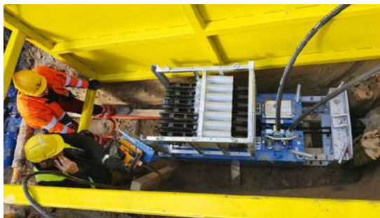
In foto Il sistema berstlining statico Grundoburst 800G all'interno della fossa di costruzione in Varsavia.
