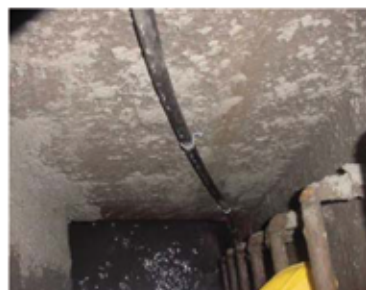
Il cavo è fissato solo lungo la parete d'ingresso
