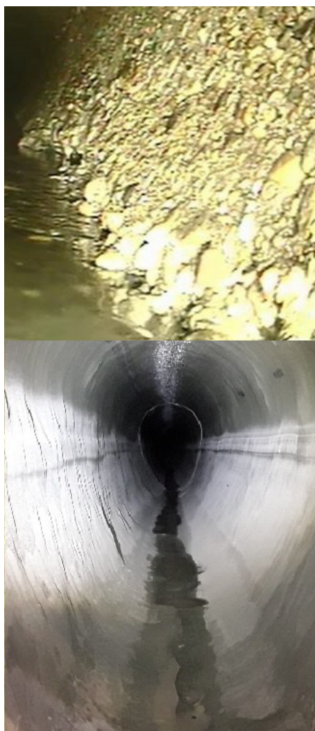
Foto: situazione pre e post intervento di relining
