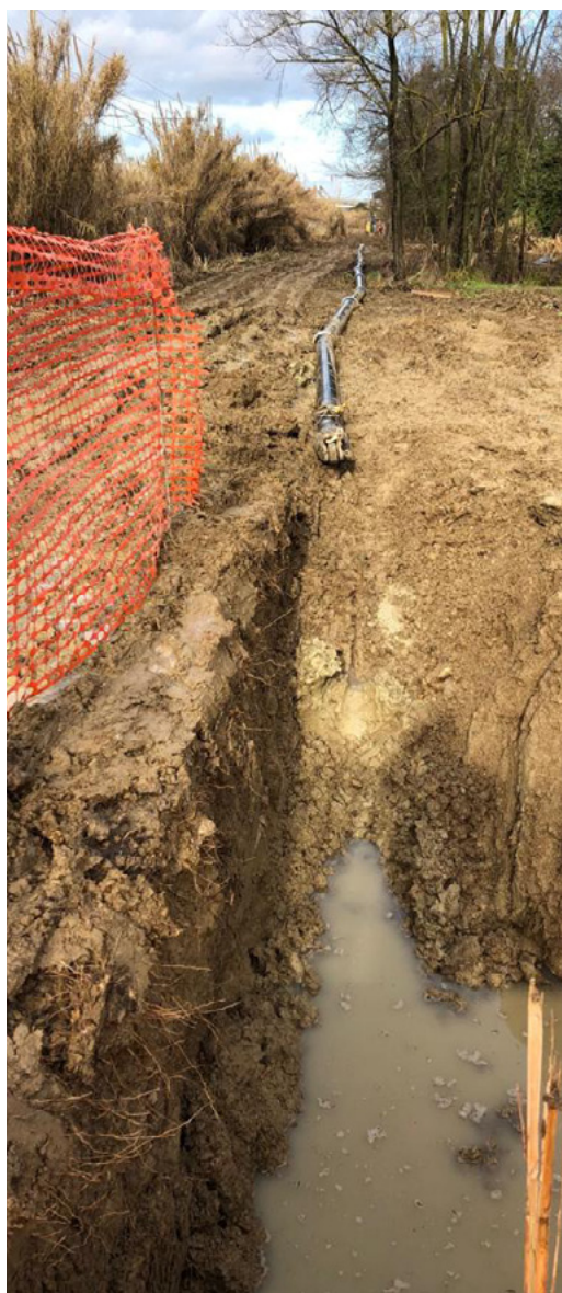
Foto: preparazione della tubazione in ghisa per il tiro in sede
