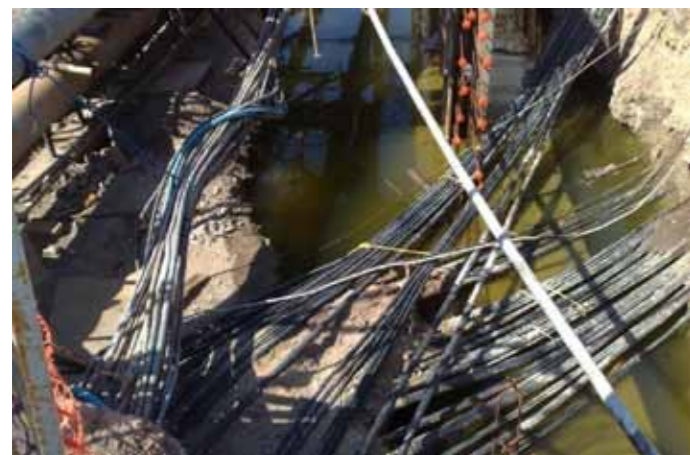
Fig.2 - Frequente situazione di caos dei sottoservizi in area urbana Fig. 2 - Recurring chaos circumstance of urban area subservices
