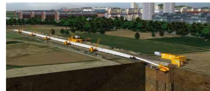
Fig. 6: Tipico allestimento di un cantiere Direct pipe Fig. 6: Typical direct pipe jobsite setup
